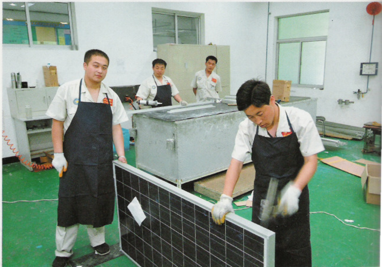
Qualität ist Tianwei Yingli wichtig, daher werden alle Zutaten für die Module aus Europa importiert. Für die Module wurden eigens nietenlose Rahmen entwickelt.
